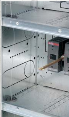
Der linienförmige Lichtsensor (auf LWL-Basis) detektiert in verschiedenen Geräteräumen.
