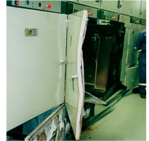
Konventionelle Schutzrelaissysteme bieten im Störlichtbogenfall keinen ausreichend schnellen Schutz.
