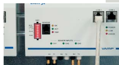
Jedes Slavemodul zur Lichterfassung beinhaltet einen Steckplatz für einen mobilen Lichtsensor. Ein aktivierter Lichtsensor wird durch eine LED angezeigt.
